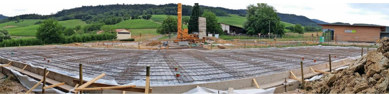
Das Fundament ist bereits gelegt, Anfang nächsten Jahres sind die ersten Veranstaltungen im neuen Kulturzentrum geplant. FOTO: SKLANG
